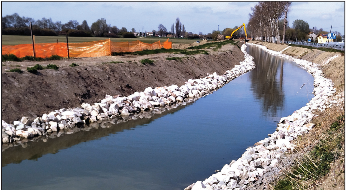
2022 Consolidamento delle sponde del Canale nel tratto Piccola Venezia - località Mora eseguito dal Consorzio Burana
